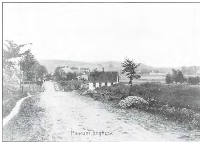
Tinghusevej i Mårumbjerg (set mod øst). Foto fra 1907.
