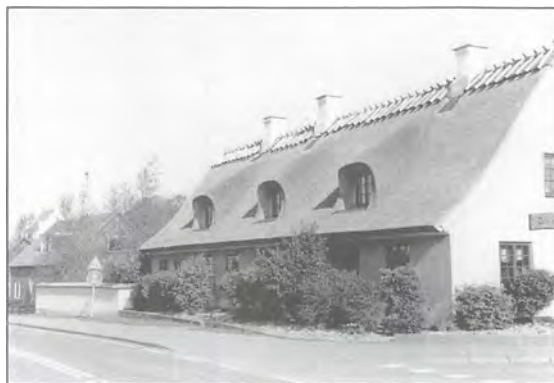
Bygningen som den ser ud i 2003. (Foto: Peter Kalko)
