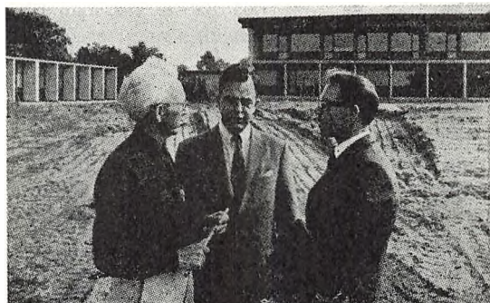
Ombygningens arkitekt Sander Hansen (tv), formanden for A/S Kobæk Strand, kontrollør Jens Christensen samt kursus- og feriecentrets direktør, E. C. Rasmussen foran et udsnit af den nye hovedbygning; tv. ses det moderniserede og udvidede »Vesterled«.
