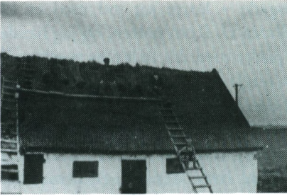
Ottar og jeg lægger nyt tag på huset Under Højene.
