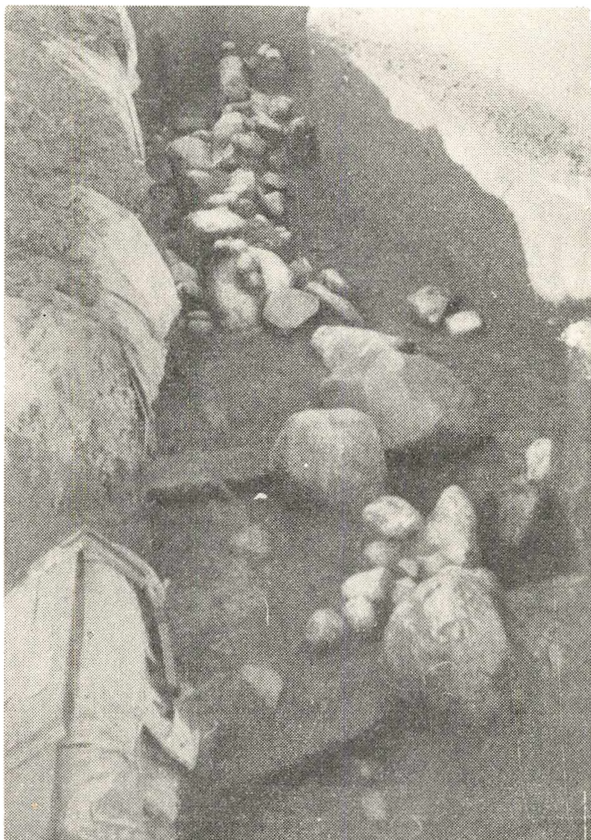
Fig. 2. Grøft set fra øst. Rørledningen er dækket med papirsække som beskyttelse mod frosten.
