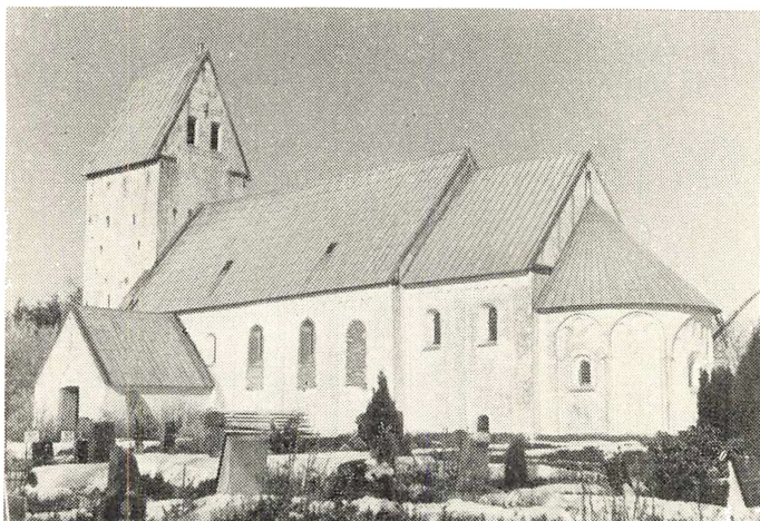
Fig. 1. Billum Kirke (set fra sydøst). De store Vinduer i Sydsiden under Tilmuring til deres oprindelige Form.
