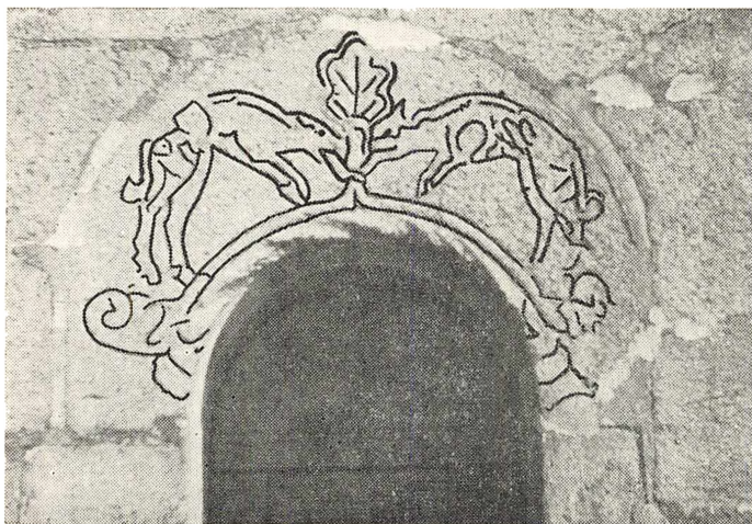
Fig. 15. Overligger over den gamle Præstedør.
