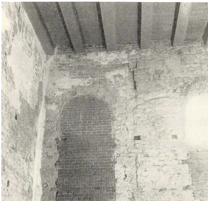
Fig. 5. Spor af Skel i Sydæggen. (Der er ikke Forbandt i Muren over det andet tilmurede Vindue).
