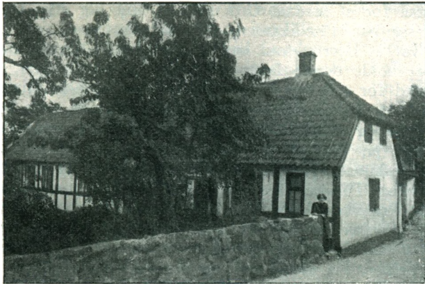
Avlsbruger Grønbechs Hus (den tidligere Byskrivergaard) med Trandbergs Mødesal længst til Venstre.
