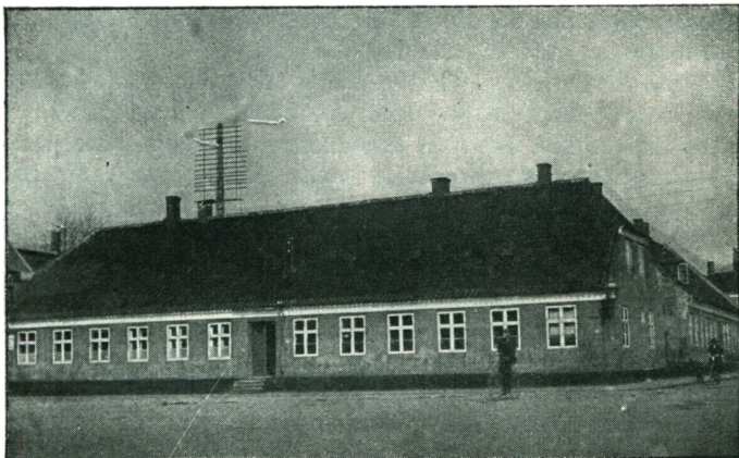
Rønne gamle Borgerskole, opført 1809 og 1825.
