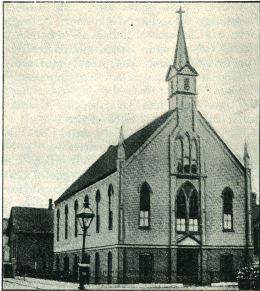
Trinitatis Kirke i Bickerdike Street (1878—85).
