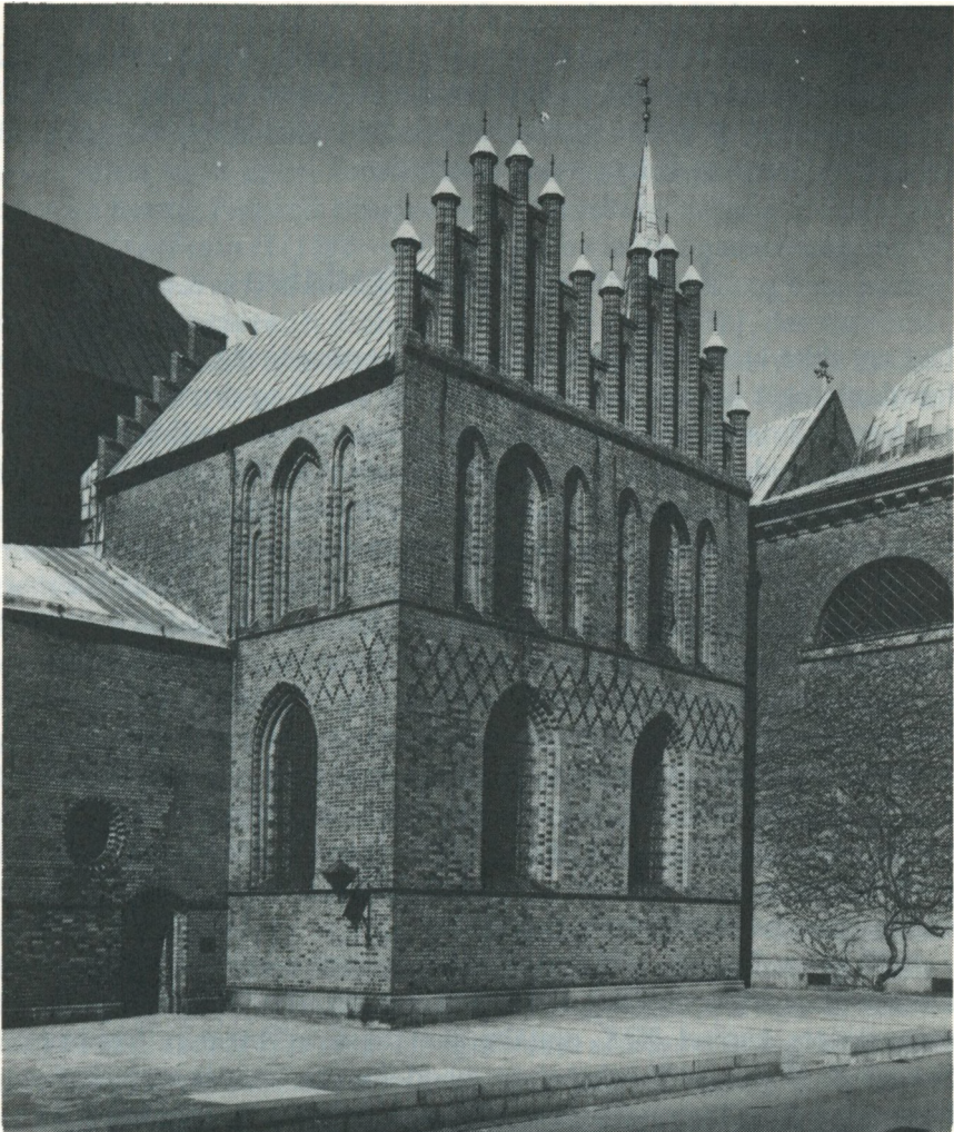
Fig. 2. Hellig Tre Kongers Kapel ved Roskilde Domkirke set udefra. Kapellet rejstes 1459 af Christian I for at være bl.a. familiegravsted for de oldenborgske konger. Ved sydvæggen under vinduerne har Johans og Ernsts barnegrave ligget.
