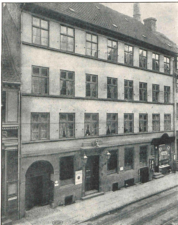
KRISTIANSHAVNS APOTEK, TORVEGADE 19.
