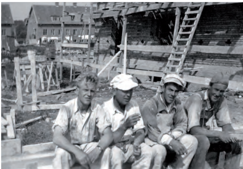
Et funktionærhus under opbygning
