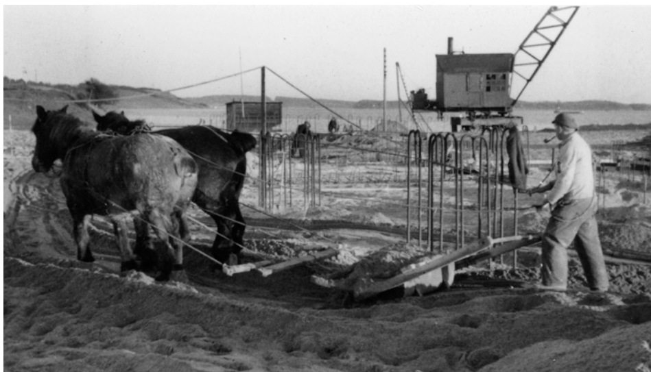
Igangsættelse af byggeriet sker med rigtige hestekræfter
