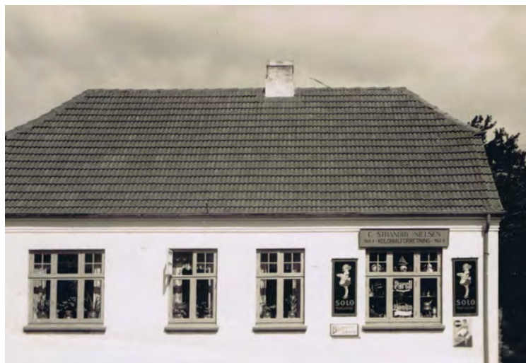
Forretningen på Skærbæk Havnegade 16
