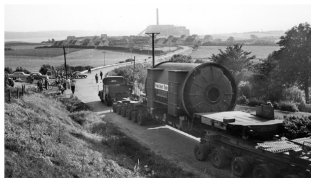
Den første turbine fragtes ned ad Kræftværksvej
