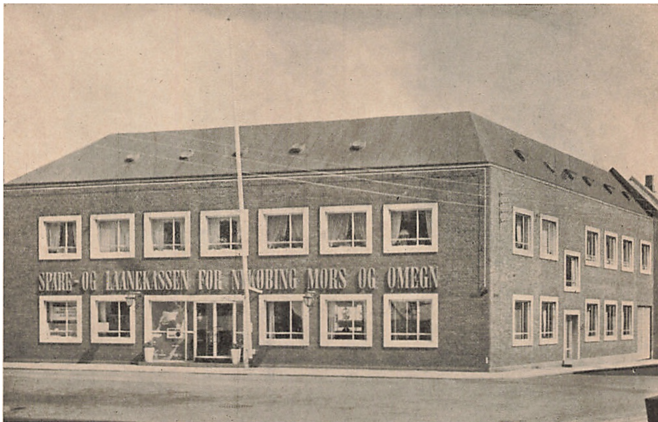
Den nye Sparekassebygning paa Hjørnet af Havnegade og Kirketorvet.
