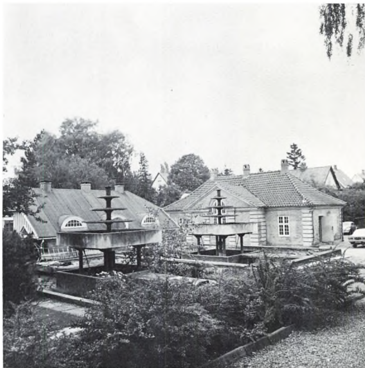
Tikøb Sogns Vandværk anlagt i 1910 på Rørtang- vej, i dag Klostermosevej, ophørte 1969. Registreret 1977.
