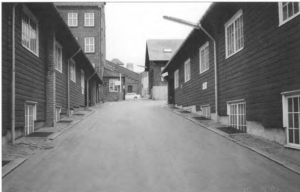
Et kig mod Jægergårdsgade fra værkstedsområdet. I baggrunden den fredede administrationsbygning, opført 1909. Foto: Viggo Lovdal, 1996.
