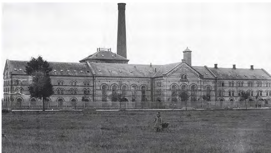
Odense Sukkerkokeri - en prangende fabriksbygning fra en optimistisk tid. Foto 1896.
