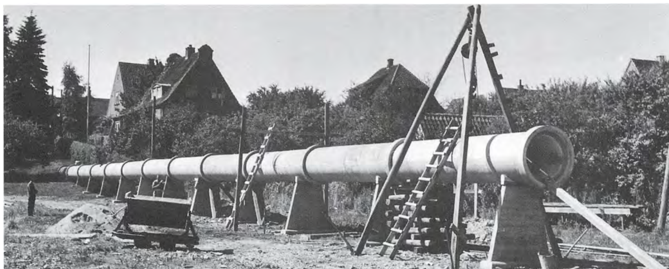
Bolbro Rende er i dag usynlig, bortset fra en lille stump nord for sognegrænsen. En del af renden blev lagt i betonrør i 1952.
