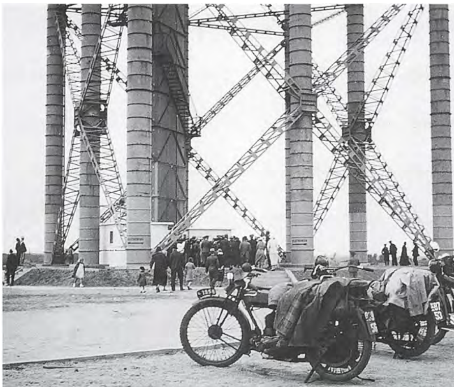
Odins Tårn var bygget af stålør fra Lillebæltsbroens sænkekasser. Privatfoto: K. Struve.
