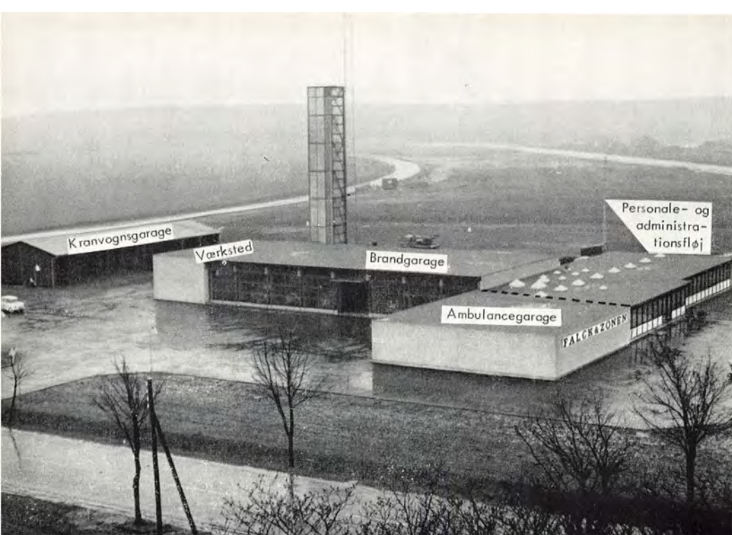
Brand- og reaningsstationen i Nykøbing Falster, opført 1967–68, taget i brug den 18. juni 1968. Lokaliteterne er vist på billedet. I baggrunden ses slange- og øvelsestårnet, der er 20 m højt, og ved siden af antennemasten, der er 46 m. Der er udvidelsesmuligheder, for grunden er på ca. 14.000 m 2 .
