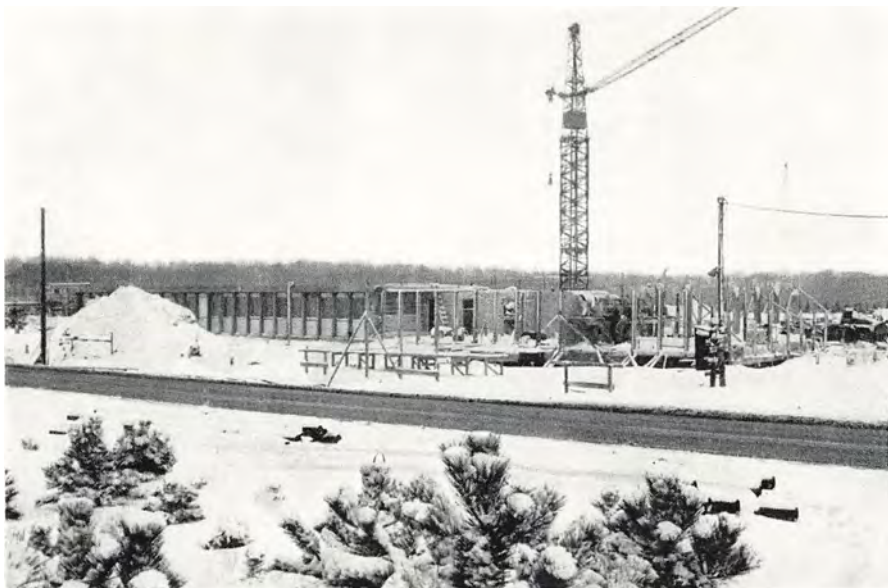
Nybyggeriet i Nyborg, der forventes tilendebragt i sommeren 1969.
