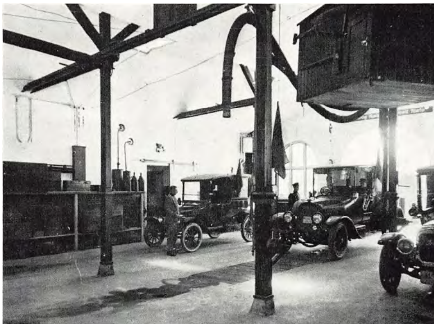
Den efter datidens forhold meget moderne udrykningshal i Odense. Kassen øverst til højre kunne sænkes ned på en fladvogn og på få minutter ændre denne fra autotransport- til redningsvogn. En idé som moderne vognmænd er ved at tage op igen.
