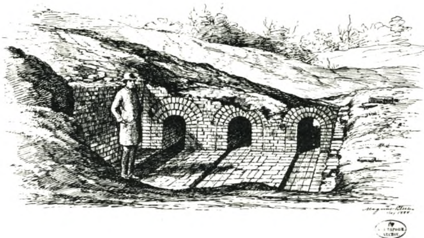
Fig. 1. Tegning af Magnus Petersen fra 1888 af udgravning i en almindelig åben teglovn fra omegnen af Svendborg. Personen står inde i den tømte oven, der har tre rundbuede indfyringsåbninger og lave bænke til opstabling af sten.
