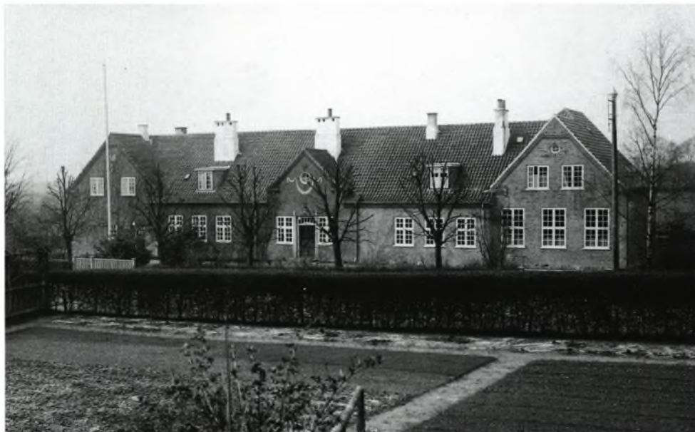
Skolens østfacade efter tilbygningen 1929
