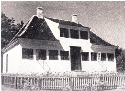
Den gamle Byskole i Kerteminde, som nu er flyttet til Den gamle By i Aarhus.
