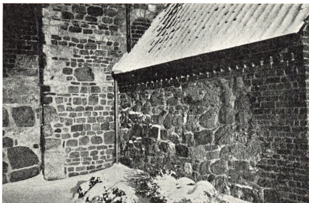
Et tilmuret, romansk vindue ved våbenhusets tag mod vest. Våbenhusets vestside er opført af kamp- og frådsten samt munkesten.
