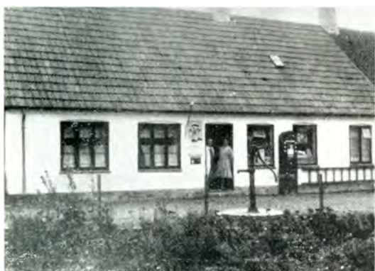
Fensmark gamle Bryggeri efter Ombygningen.
