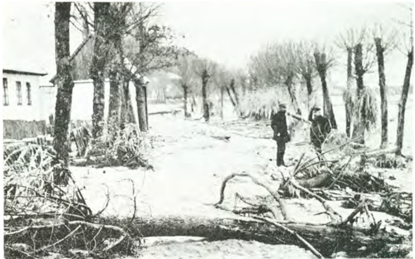
Stormflodens Ødelæggelser ved Fakse Ladeplads.
