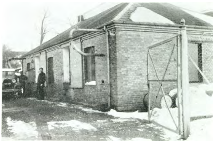
Tankanlægget ved Havnen.
