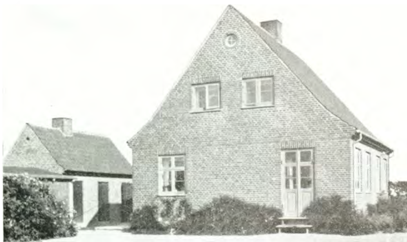
Dalby Lægebolig før Ombygningen.
