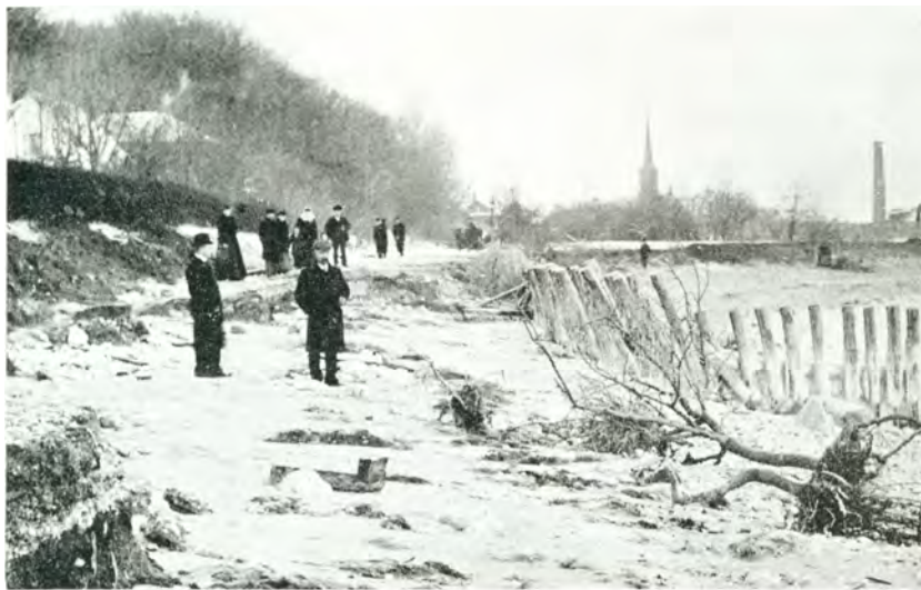
Stormflodens Ødelæggelser ved Fakse Ladeplads.
