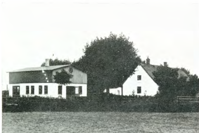
Den gamle Skole, der nu er Lægebolig, med det i 1909 byggede Karetmagerværksted.
