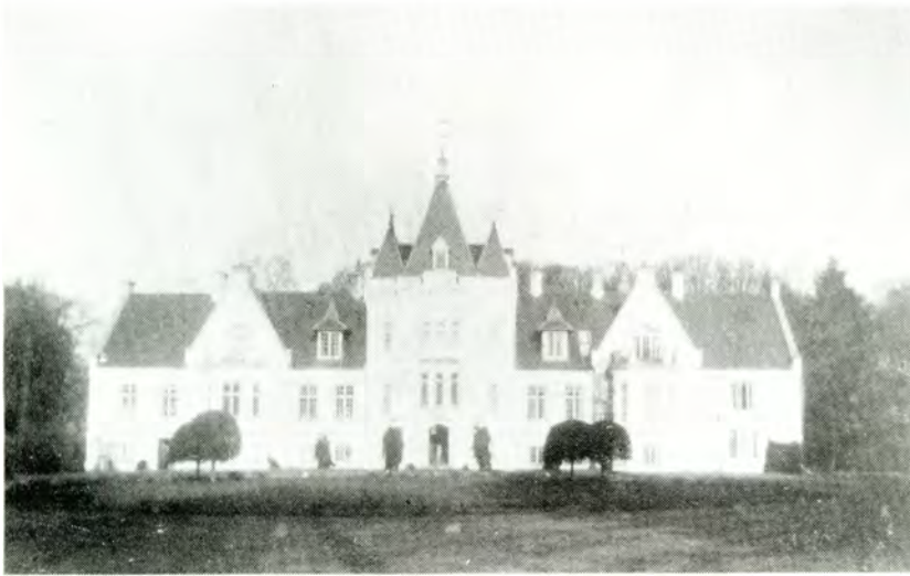
Oremandsgaard Hovedbygning før Branden i 1933.
