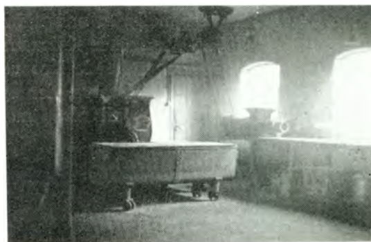
Interior af Bageriet.
