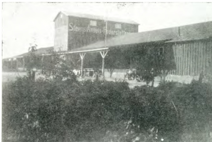
Stevns Andels Foderstofforenings Bygning.
