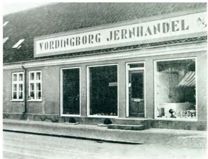
Vordingborg Jernhandels Forretning.
